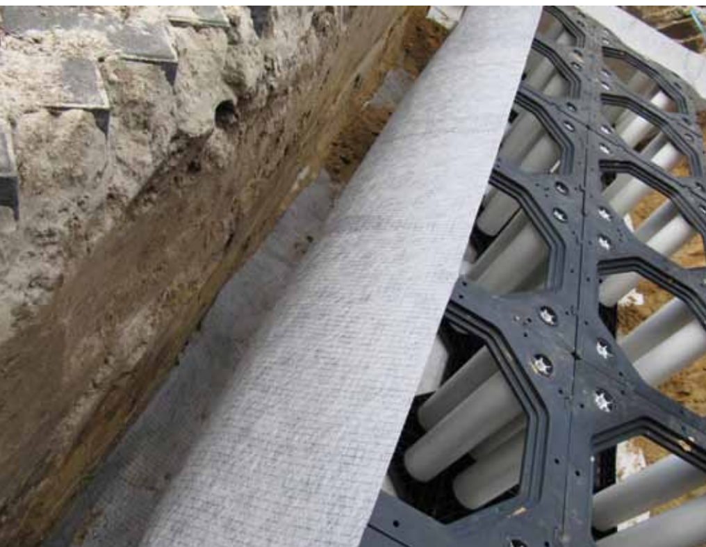
Het hele systeem is een boombunker inclusief waterafvoer.
