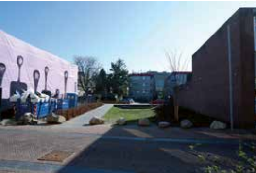
Aanleg van de Grifthof
