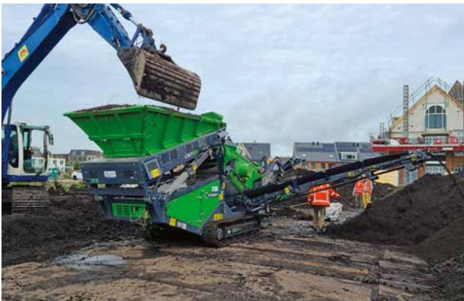
Grond afgraven en zeven
