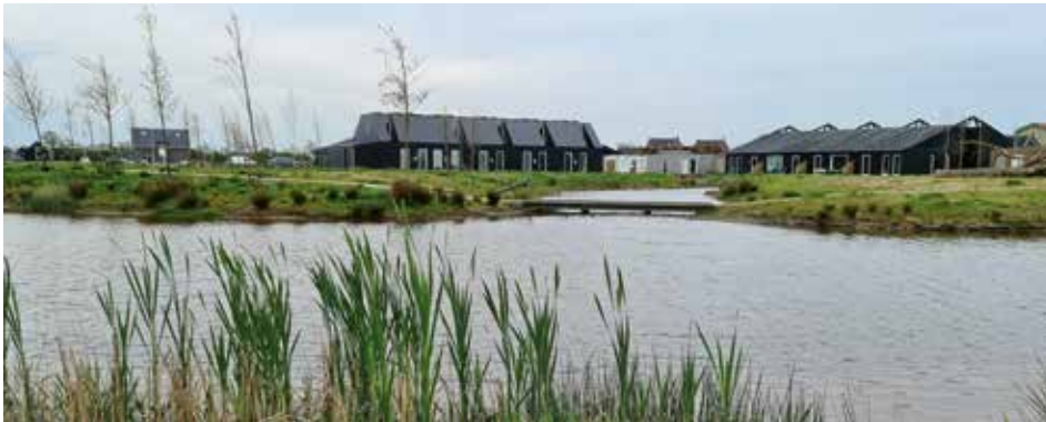
Buurtskap de Tuunen in aanbouw
