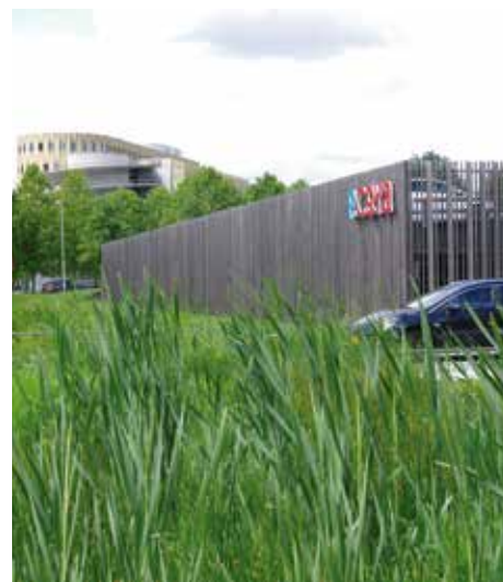
Een lamellenwand houdt geparkeerde auto's uit het zicht.
