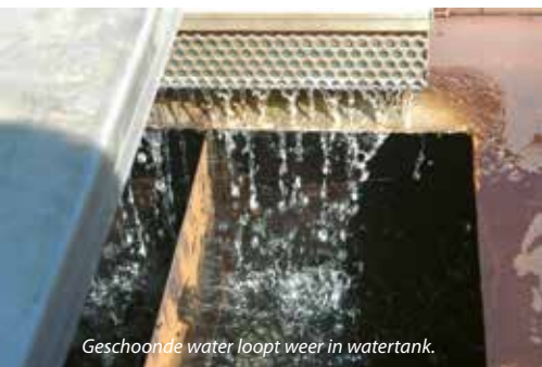
Communicerende vatenwerking stuwt gebruikt water door kunststof filters.
