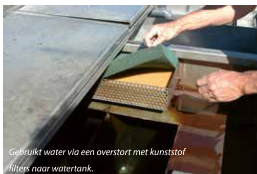
Overgestorte gebruikte water komt op fijn rvs-filter.
