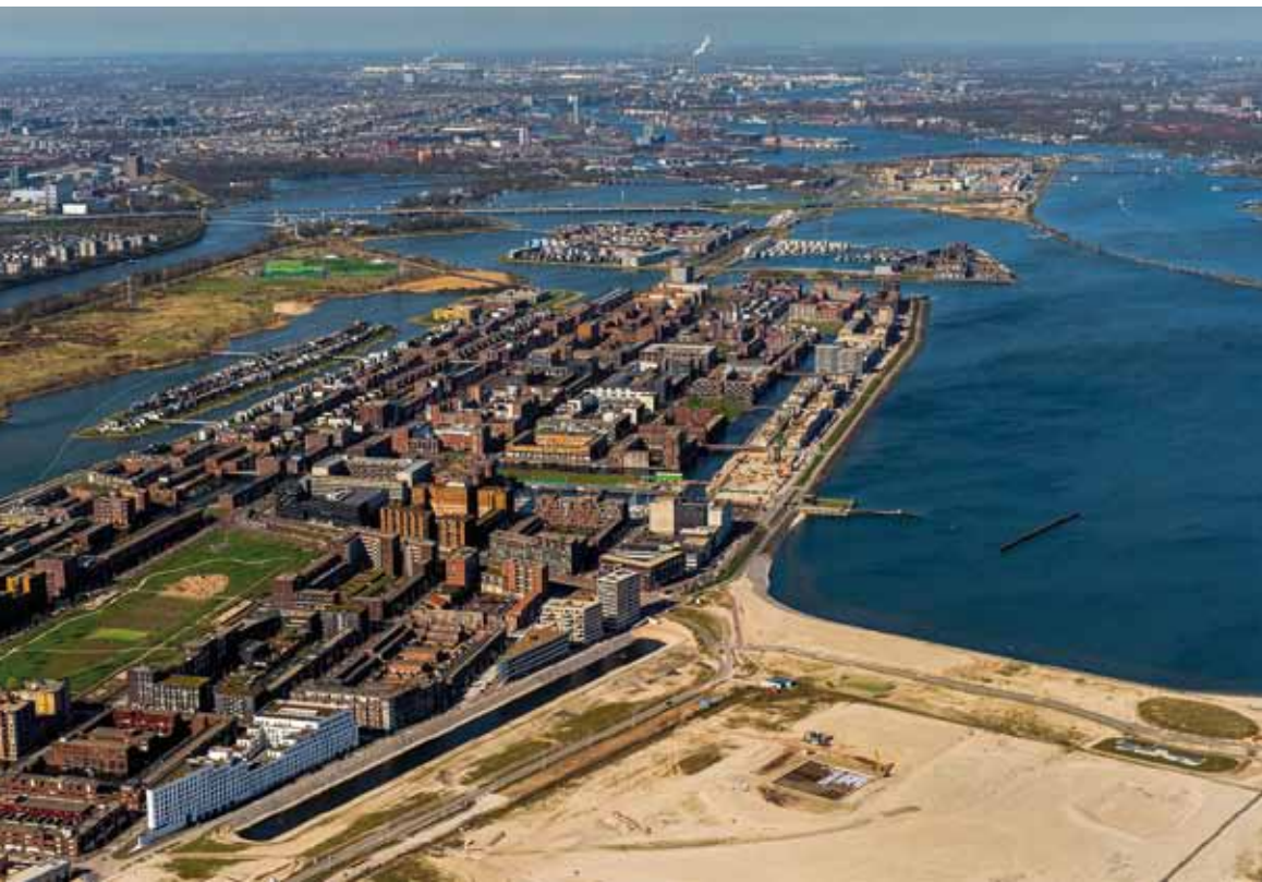
Luchtfoto aanleg Bomencarré Centrum-eiland.
