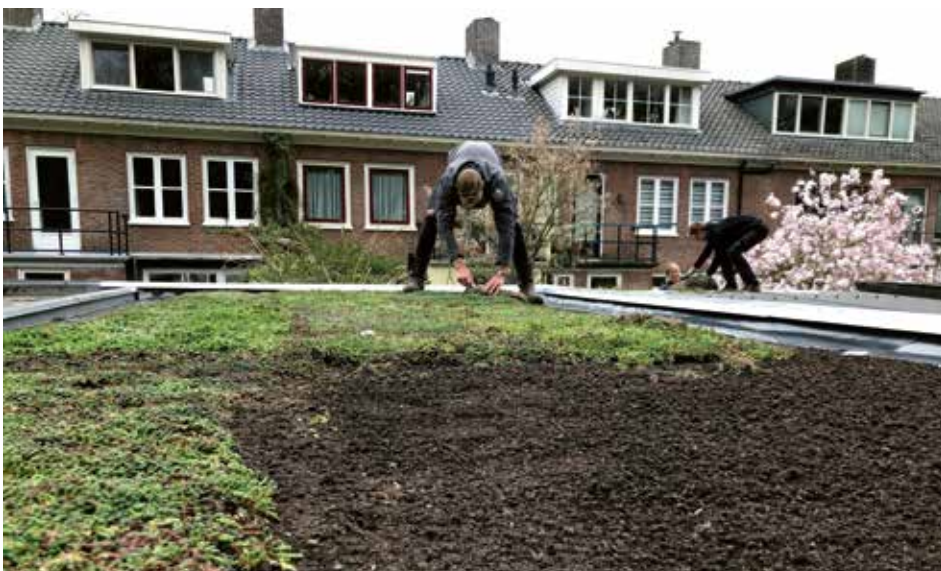
Aanleg groen dak. Foto: gemeente Arnhem
