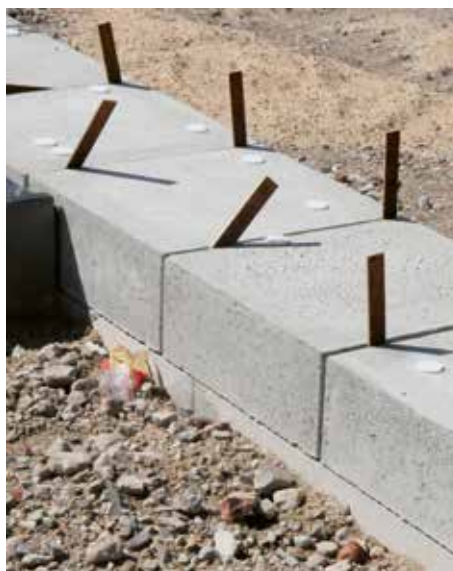
De nieuwe oud-Hollandse tegel worden met afstandhouders gelegd en daarna ingestrooid met grit
