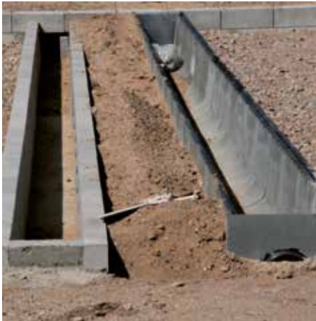
Rechts de watergoot en daarnaast de kabelgoot met springen
