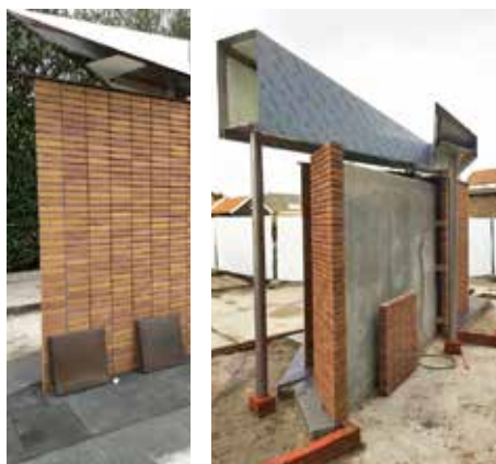
Niets is aan het toeval overgelaten. Materialen en opstellingen zijn getest in een levensgrote mock-up. Foto: Paul Rohlfs
